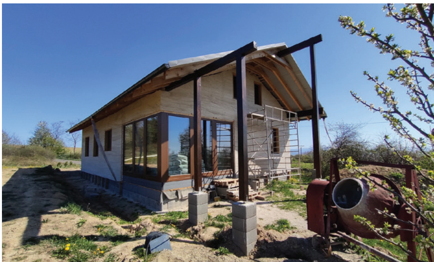
Obr. č. 2: Jeden z prvých domov na území Slovenska postavený metódou výplňovej drevenej nosnej konštrukcie konopným betónom. Foto: Pavol Kocan, projekt: Ateliér ARCHA
