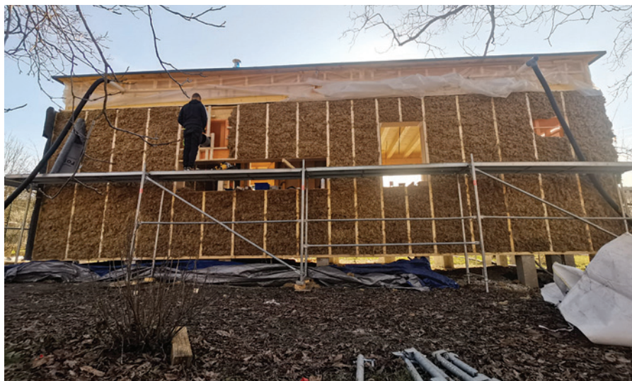
Obr. č. 8: Konopný dom so sendvičovou skladbou, kde je okolo nosnej drevenej konštrukcie ukladaný konopný betón, na to do roštu ukladané konopné vlákno zaklopené drevovláknitou doskou. Spolu s omietkami a obkladom je to veľmi precízne zvolená konštrukcia na elimináciu tepelných mostov a vyladenia pomeru akumulácie a odporu. Foto: archív Ateliéru ARCHA
