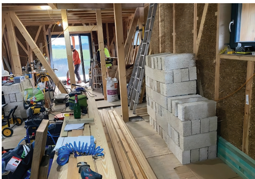
Obr. č. 11: Interiér rozostavaného domu z panelov EcoCocon a z kvádrov z konopného betónu
